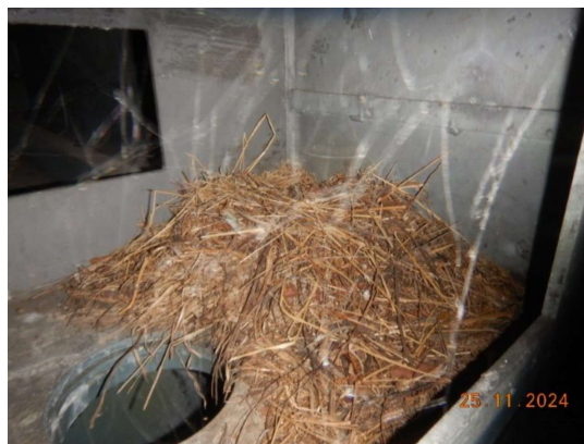
RIEGEL INNEN VERSCHMUTZT
