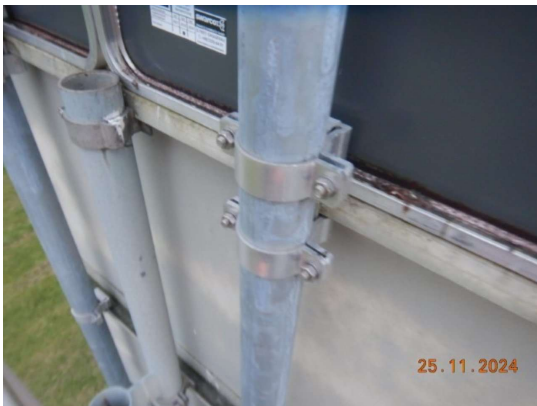
SICHERUNGSMUTTER FEHLT
