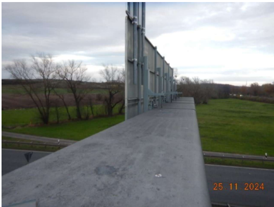
KORROSIONSSCHUTZBESCHICHTUNG AUF METALL VERFÄRBT
