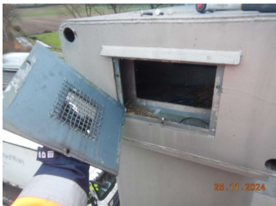
SICHERUNGSKETTE DER BESICHTIGUNGSLUKE FEHLT
